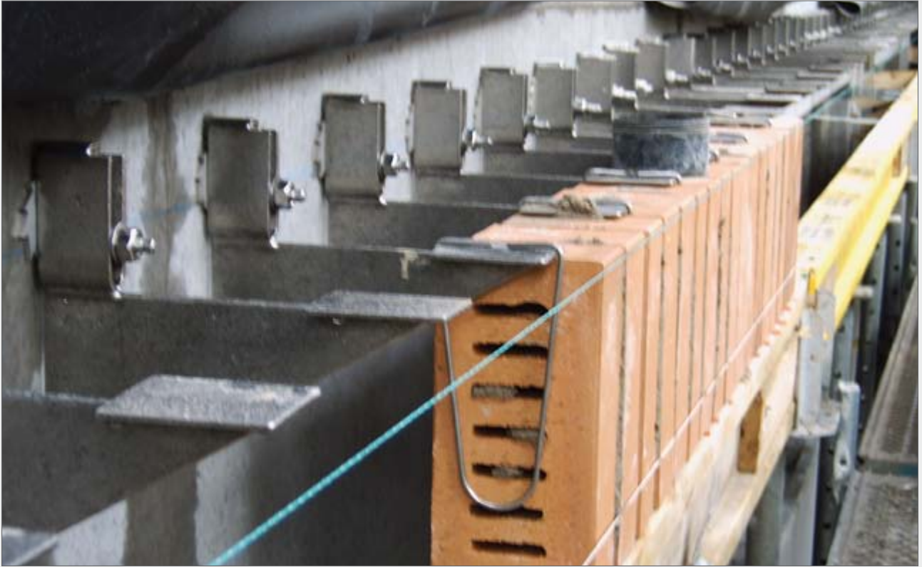
ELMCO–KV-GB mit Unterbügel ELMCO–CB → Seite 37
