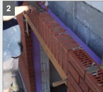
2 Um den letzten Grenadier im Sturz zu setzen, wird der Stein wie abgebildet eingeschlitz.
