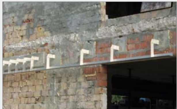
Sonderausführung Einmörtelkonsolanker ELMCO–MA-V als verschweißte, durchlaufende Winkelkonstruktion für die Sanie- rung von Gebäuden → Seite 35
