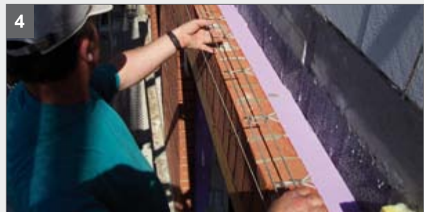
4 Tragelement von vorn in die beiden offenen Enden der Unterbügel einschieben
