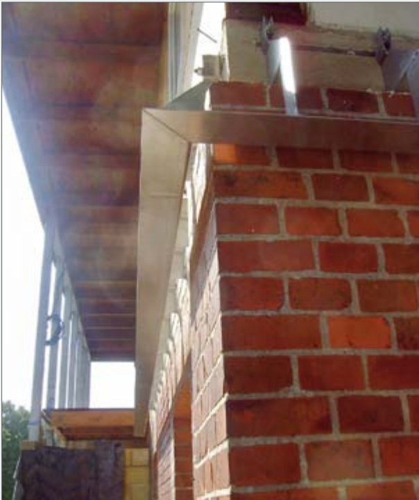
Individuelle Winkelkonstruktion ELMCO–WS mit Ankerpunkten Ausführung KV-GA als verschweißte Eckausführung
