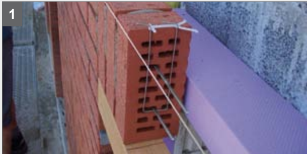
1 Grenadiere mit Vernadelung mauern, dabei alle 25 cm einen Unterbügel einbauen
