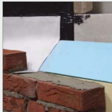
Sperrfolie-Vlies, befestigt mit Kleber "BV"
