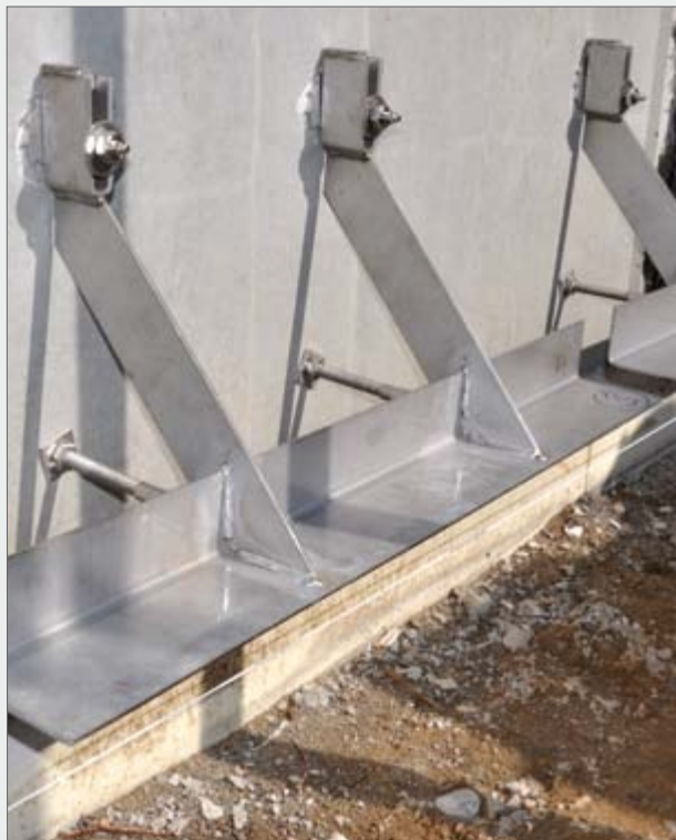
ELMCO–W mit Ankerpunkt ELMCO–KV-GA (individuelle Sonderausführung)
