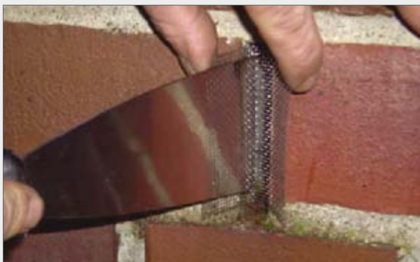
Einfach mit einem Spachtel in die Lüftungsfuge drücken
