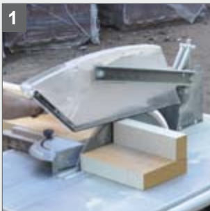
1 Zuschneiden der Zargen
