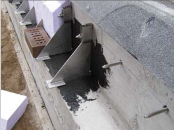
ELMCO–KV-GA → Seite 30 als Fußpunktabfangung
