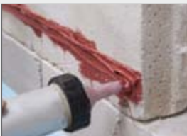
Hintermauerwerk inkl. Dämmung herstellen, ELMCO–Sperrfolienkleber auftragen
