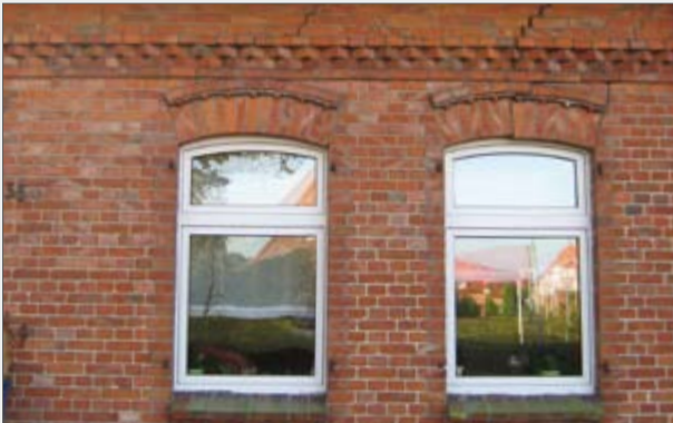
Sanierungsfall Fenstersturz
