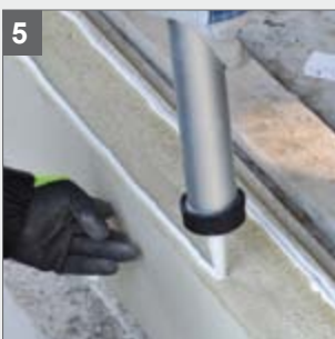
5 Auftragen des Soforthaft-Klebers in zwei Strängen auf die Zargen
