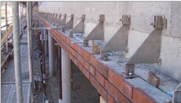
ELMCO-KV-FT-ES-SK mit Versatz, Laststufe 10,5 kN
