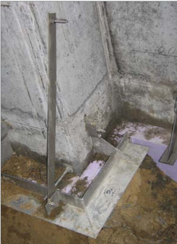
Beispiel ELMCO-KV-GA - Eck, Sonderausführung mit Schrägzuganker
