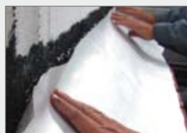
ELMCO–Sperrfolie-Vlies positionieren und andrücken
