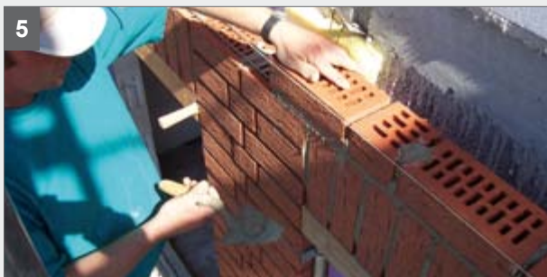
5 Läuferschichte über dem Grenadiersturz mauern
