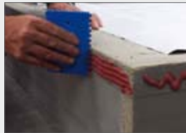
ELMCO–Sperrfolienkleber mit Zahnpachtel auf 50 mm vollflächig verteilen
