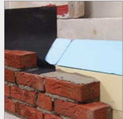
Sperrfolie-EPDM, befestigt mit Kleber "NB"
