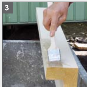
3 Reinigen und anschließendes Vorbehandeln der Zargen mit dem Primer
