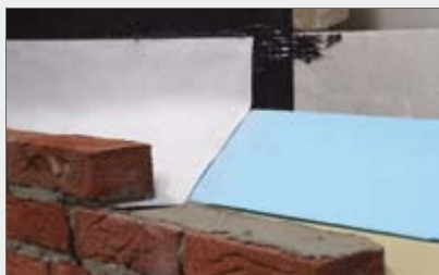
Befestigung der ELMCO–Sperrfolie-Vlies auf bituminösem Untergrund
