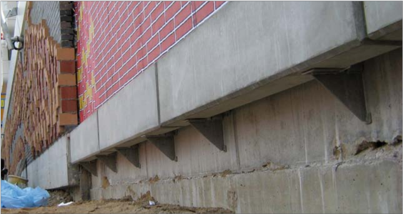
ELMCO–KV-GB → Seite 32 als Fußpunktabfangung
