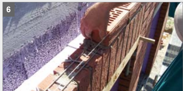
6 Alle 25 cm einen oberen Klemmbügel in das Tragelement einbauen, den Bügel dabei etwas zusammendrücken
