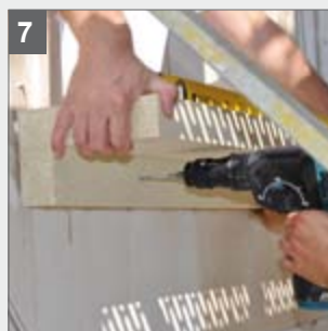
7 Sichern aller Zargen mit Rahmenschrauben gegen Abrutschen
