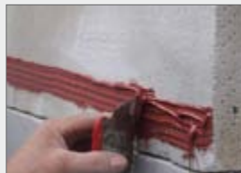
ELMCO–Sperrfolienkleber mit Zahnpachtel auf 50 mm vollflächig verteilen
