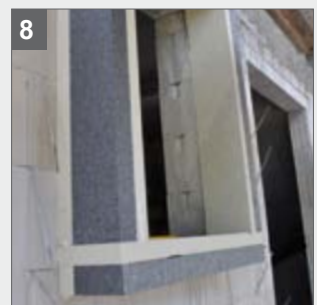
8 Bei Bedarf mit Dämmblock versehen
