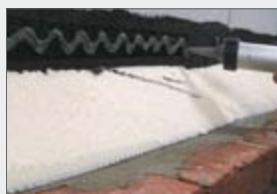
ELMCO–Sperrfolienkleber-BV auftragen, 600 ml reichen für ca. 10 m
