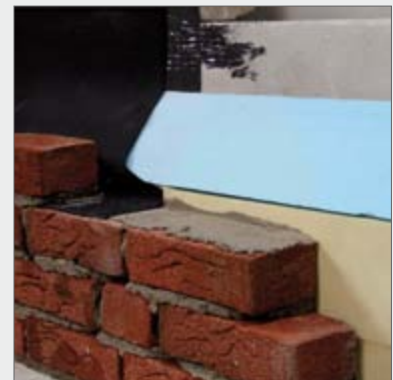
Sperrfolie-EPDM, Stoßverklebung mit Kleber "BV"
