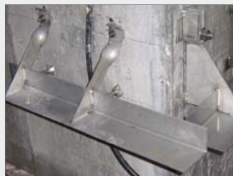
Baustellenbeispiel ELMCO–EW, Auskrägung rechts
