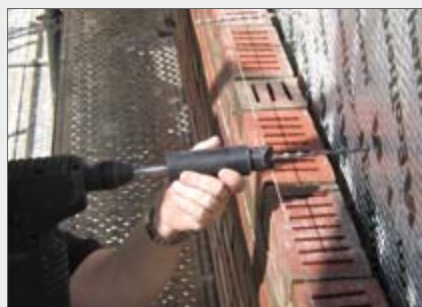
Sanierung: Nachträgliche Verankerung der Verblendsfassade
